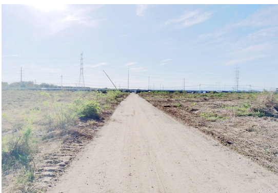
项目北侧现状道路
